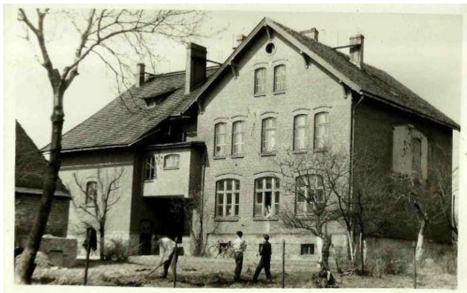
Budynek Szkoły Podstawowej w Kruszyń z 1955 roku, archiwum własne
